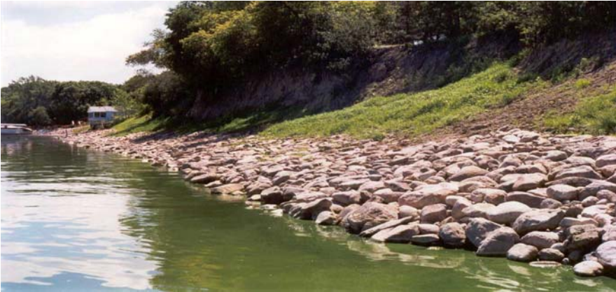
Rock Rip Rap
